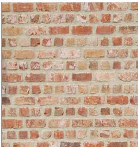
L'on applique, sur les briques neuves au look ancien, des restes de mortier artificiels
