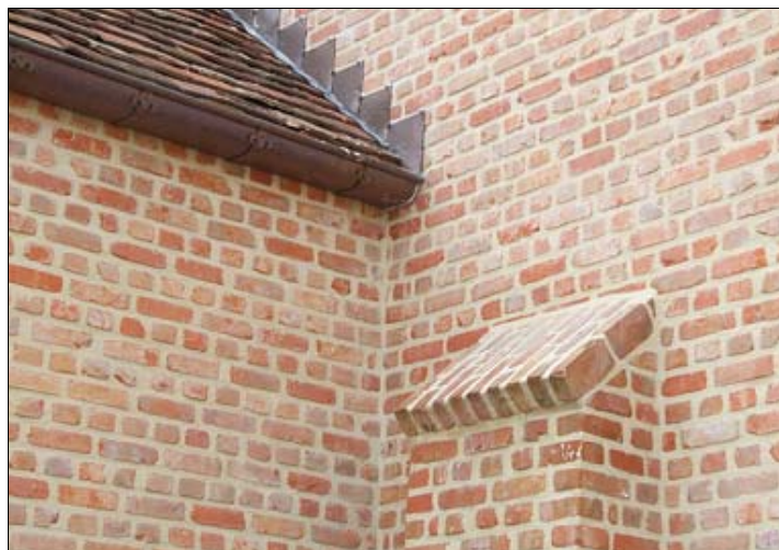
De authentieke charme van recuperatiestenen komt vooral tot uiting door de speciale kleurschakeringen, de mortelresten en de afgebroken hoekjes
