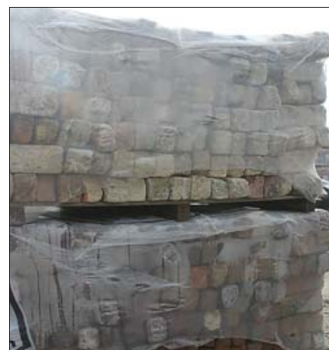
De recuperatiestenen uit een afbraak worden samengezet op pallets
